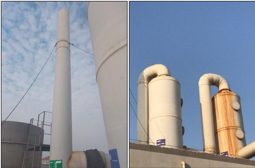
一级碱喷淋塔+一级水喷淋塔+7#排气筒
