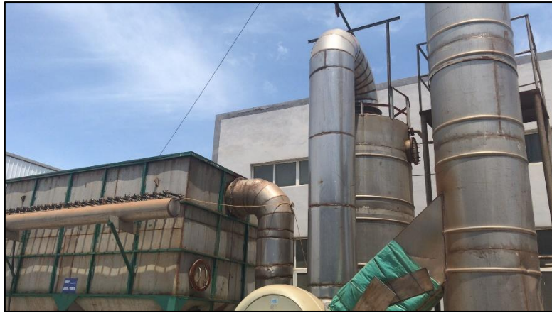
布袋除尘器+一级水喷淋塔+5#排气筒
