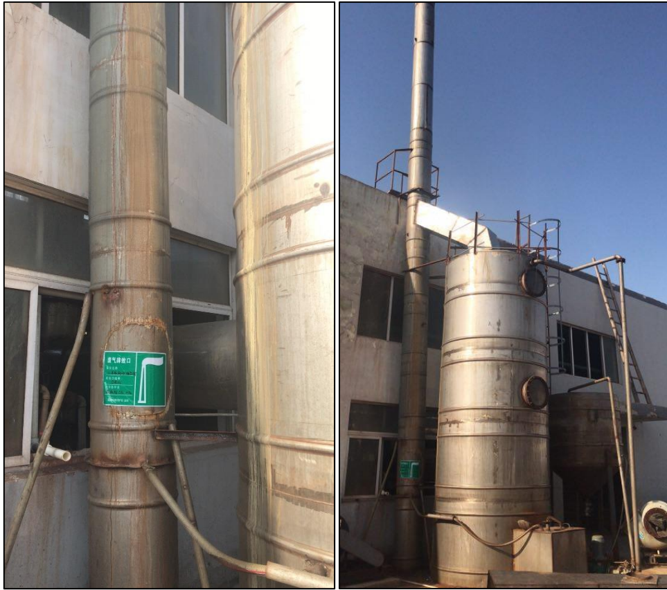
一级碱喷淋塔+11#排气筒
