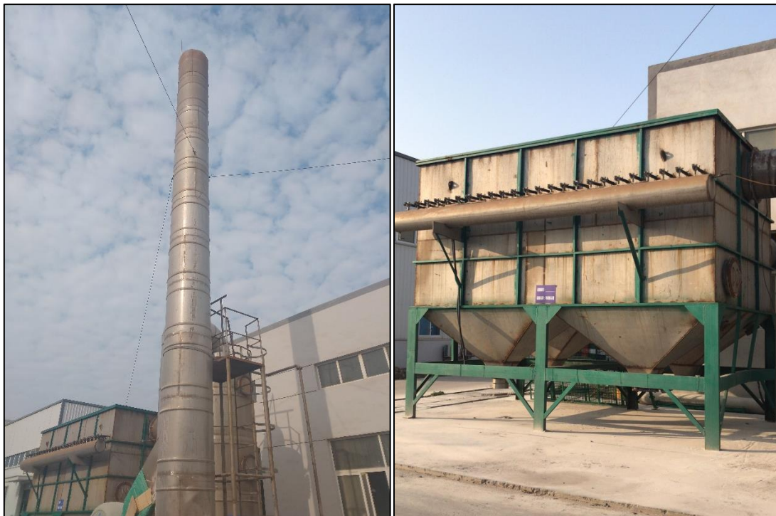
布袋除尘器+一级水喷淋塔+一级碱喷淋塔+4#排气筒
