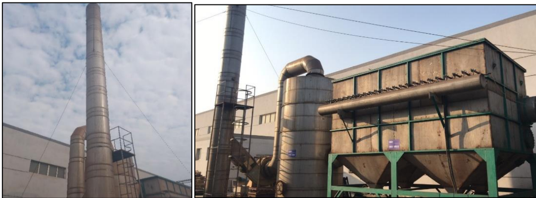
布袋除尘器+一级水喷淋塔+6#排气筒
