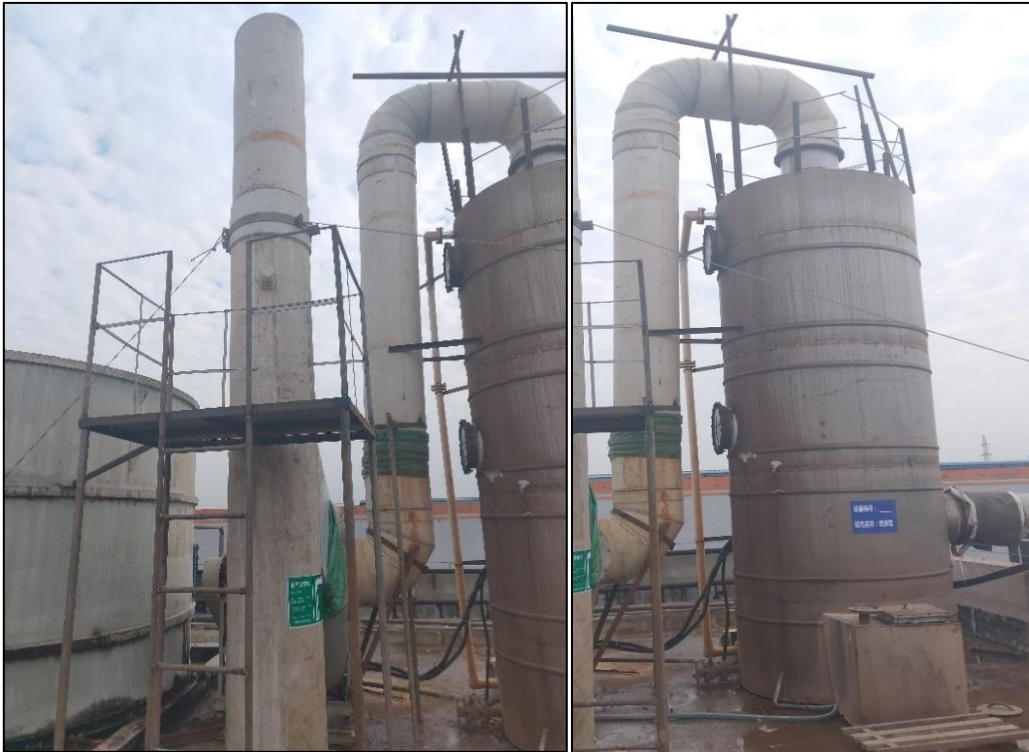
一级水喷淋塔+3#排气筒
