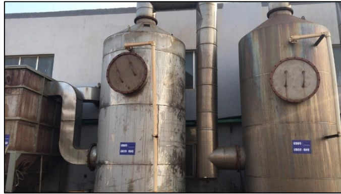
布袋除尘器+一级水喷淋塔+一级碱喷淋塔+4#排气筒
