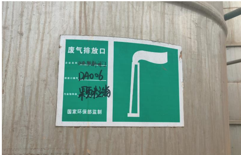
图 10-3 废气排放口标志牌
