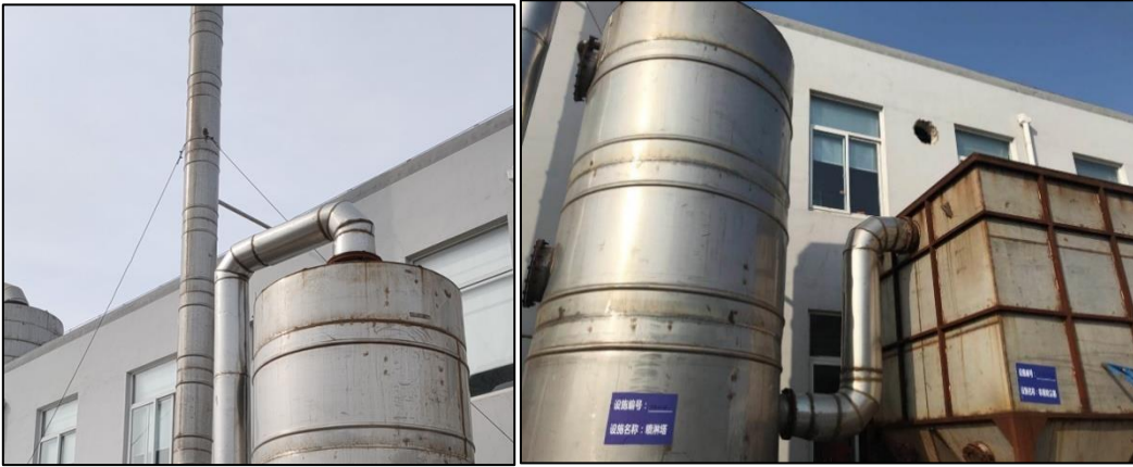
布袋除尘器+一级水喷淋塔+2#排气筒
